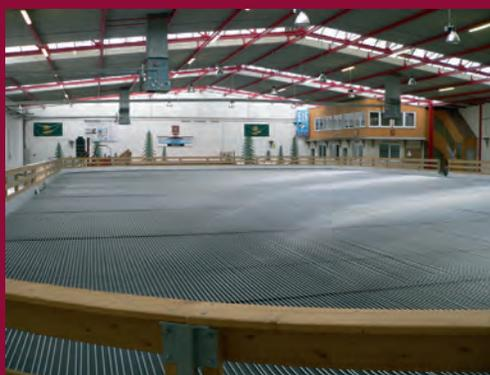
19 Kilometer Aluminiumleitungen werden auf 900 Quadratmetern in der Eishalle verlegt.
